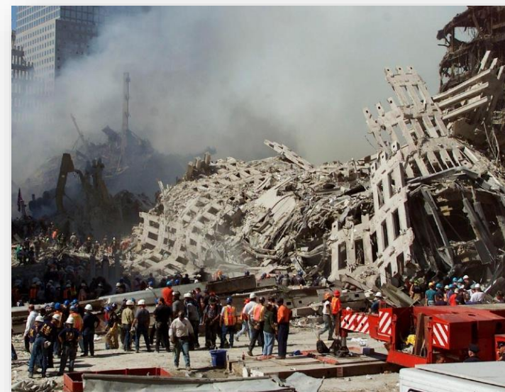
火灾下倒塌的钢框架结构
